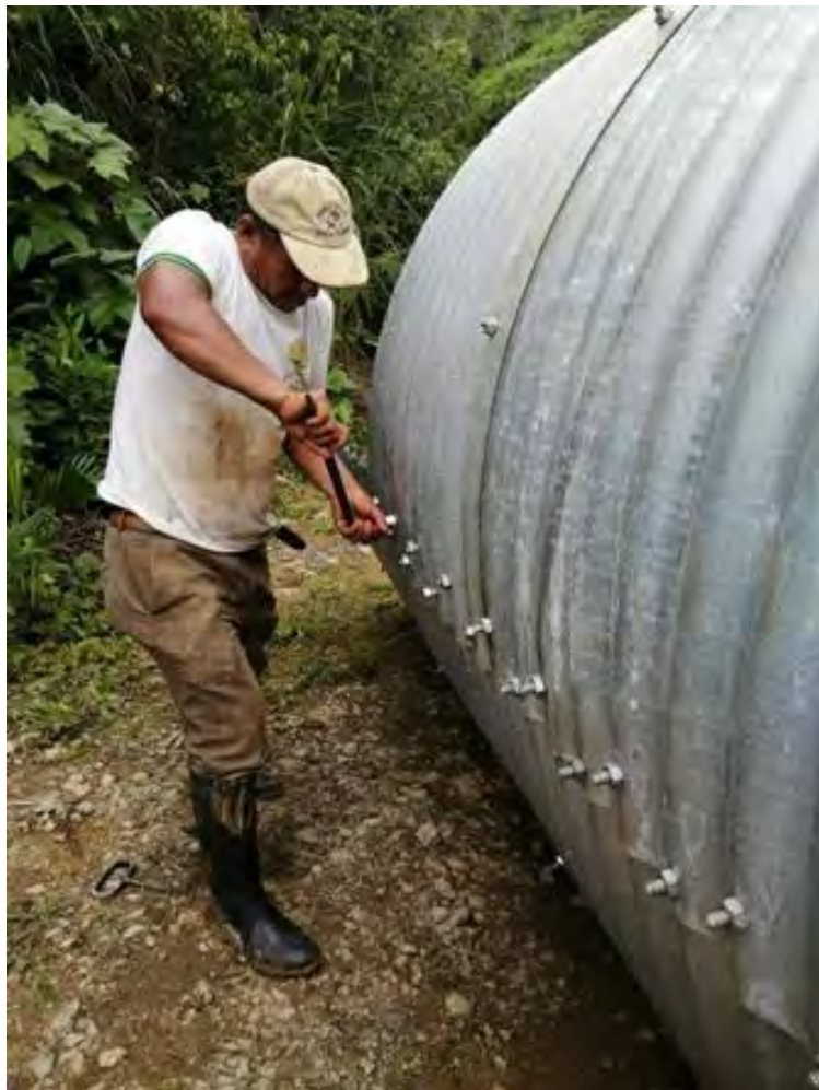
ARMADO Y COLOCACIÓN DE ALCANTARILLA, EN LA QUEBRADA NUEVA ZARUMA
